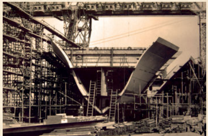
Während des Baus der Bugsektion des Schiffes
