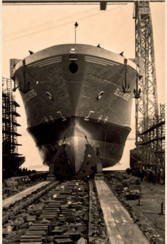
MS „Gleichberg“ beim Stapellauf von der Helling
